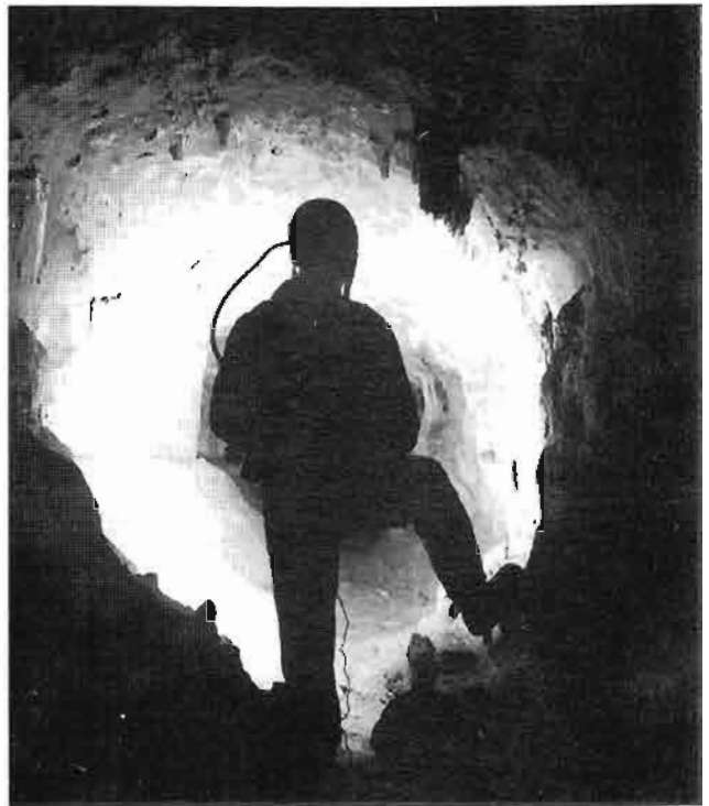
Foto 1.- Galería en tubo a presión en la entrada de las Canalejas.
